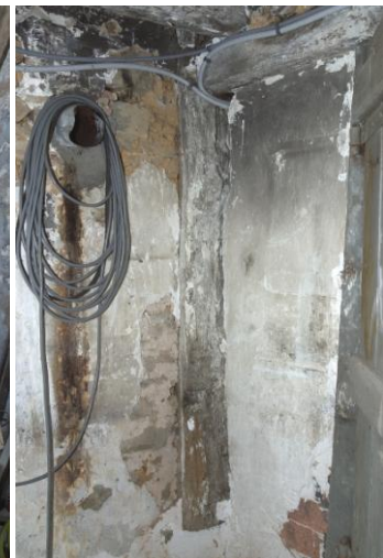
Fig. 4 - Poteau de structure enserré dans une maçonnerie postérieure : la Tuaudière à Vaiges. © Inventaire général, F. Lasa.
