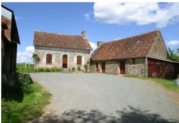
Fig. 9 - Toitures à pente forte sur l'ancien logis-étable et à pente faible sur le logis du 19 e siècle : le Petit-Bignon à Saint-Jean-sur-Erve. © Inventaire général, F. Lasa.
