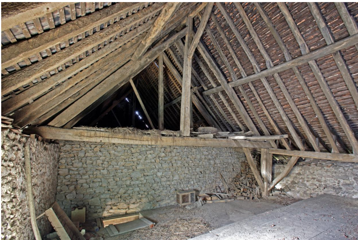
Fig. 8 - Charpente à ferme et à panne, sans faux-entrait et à embrèvement : dépendance du 8, rue de la Mairie à Torcé-Viviers-en-Charnie. © Inventaire général, F. Lasa.
