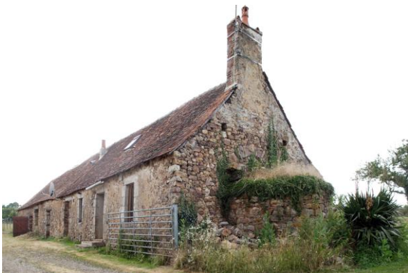
Fig. 1 - Logis-étable du 16 e ou du 17 e siècle dont les ouvertures ont été agrandies et encadrées de pierres de taille au 19 e siècle : la Boucherie à Blandouet. © Inventaire général, F. Lasa.
