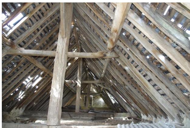
Fig. 6 - Charpente de type mixte : la Seffière à Vaiges. © Inventaire général, F. Lasa.
