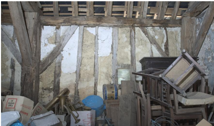
Fig. 3 - Mur en pan de bois et torchis : les Rosiers à Vaiges. © Inventaire général, F. Lasa.
