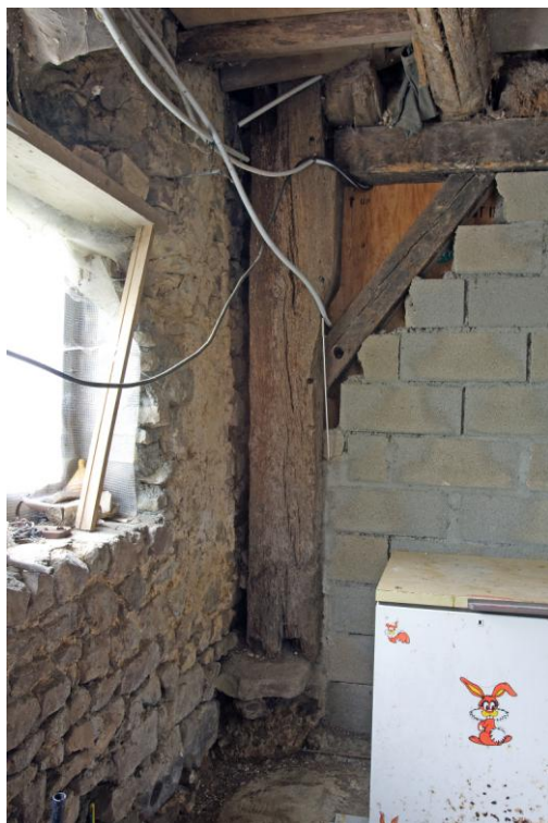
Fig. 5 - Poteau de structure placé en avant du mur : le Clou à Torcé-Viviers-en-Charnie. © Inventaire général, F. Lasa.
